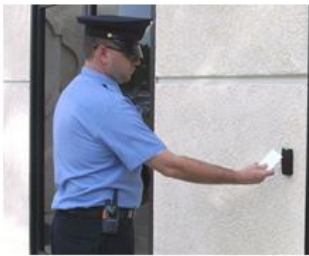
出入口控制子系统
